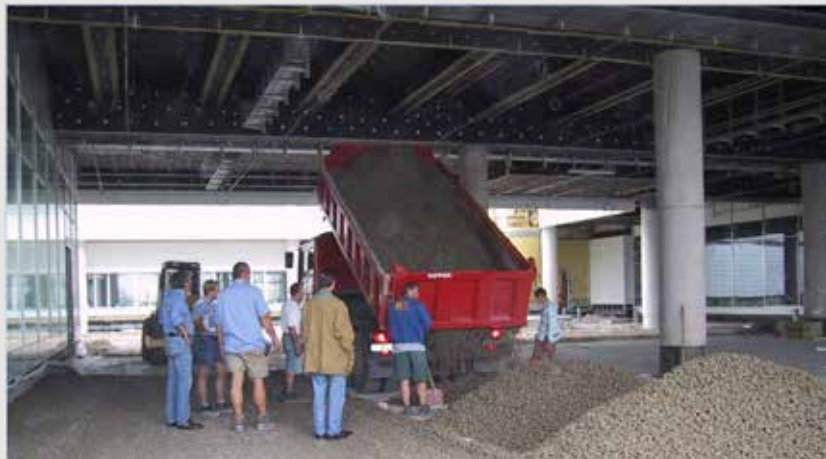
Transport depuis la centrale jusqu'au chantier
