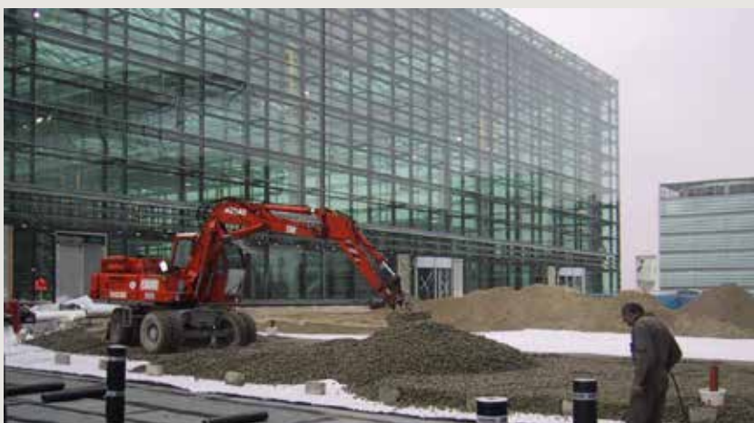
Pose et répartition du matériau au moyen d'une pelleuse
